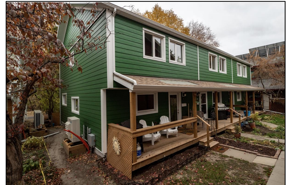
Retrofit Canada, Alberta
